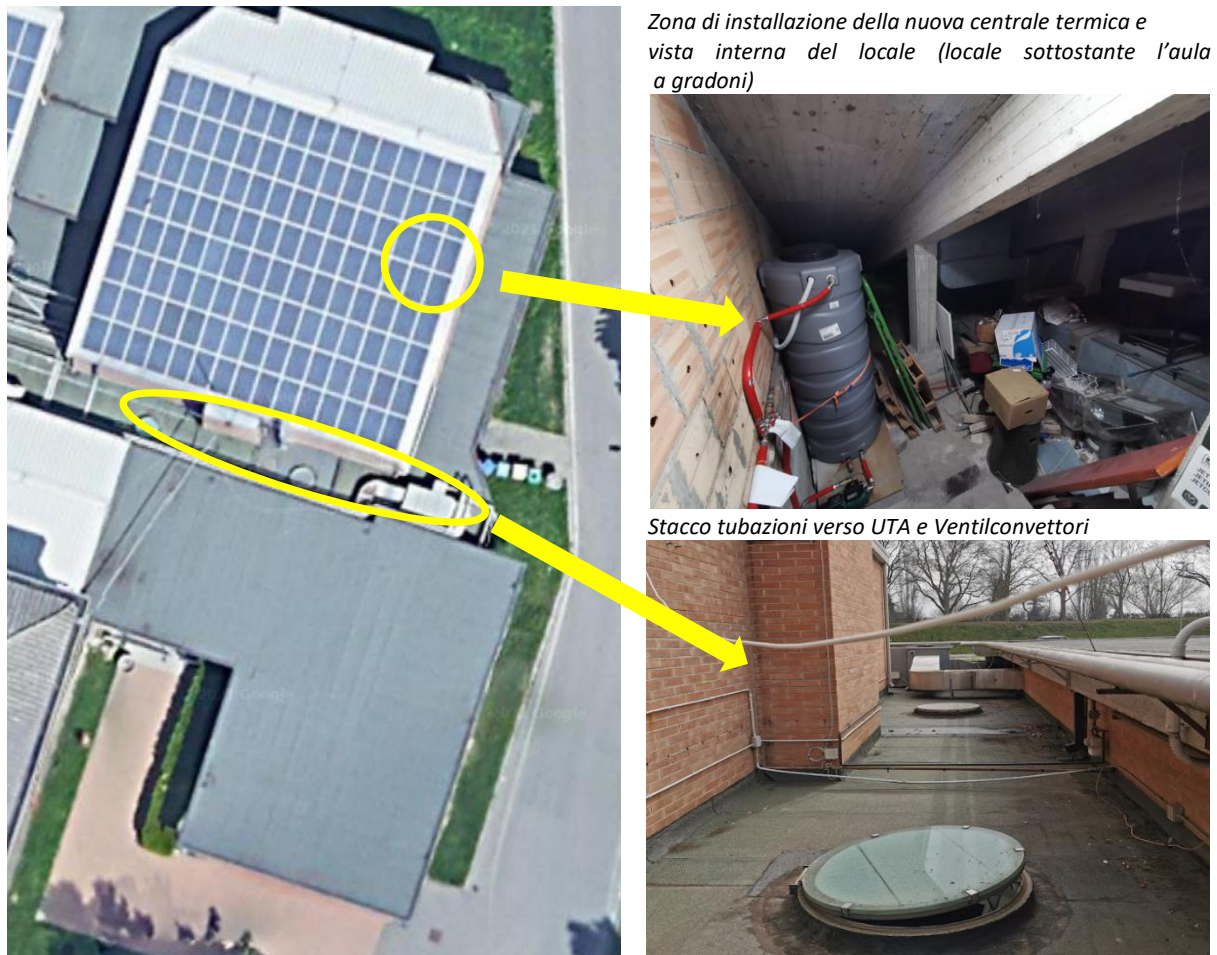
Figure 4.5 - Zona di posizionamento della centrale termica comprensiva di pompa di calore e accumuli e linea tubazioni UTA e ventilconvettori esistenti
