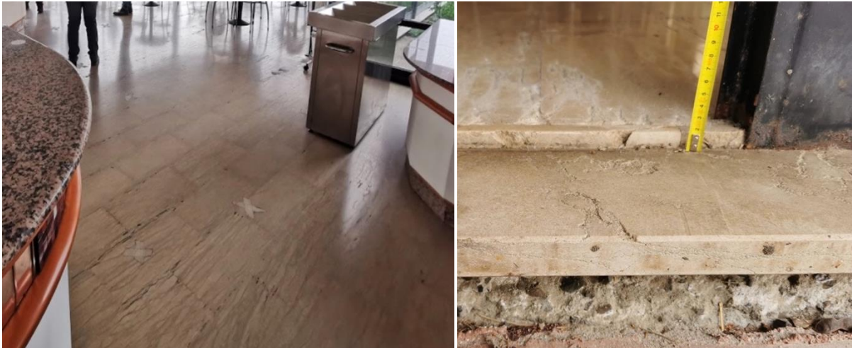
Figure 2.4 - Pavimentazione esistente nella zona bar
