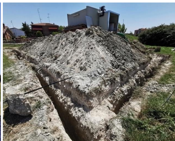
Figura 1.2. Scavi degli scambiatori geotermici (WP3)
