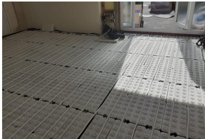
Figure 9.4 - Pavimento radiante (area blue) e bancone (area gialla); esempio di posa dei ThinICE.
